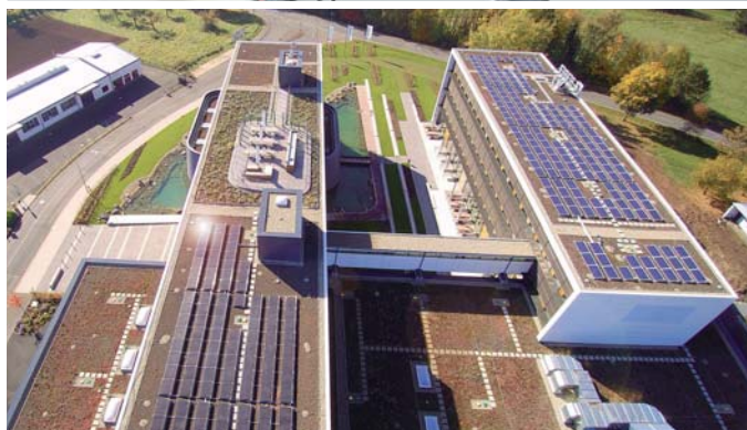
Energie wird über ein hocheffizientes Blockheizkraftwerk und Photovoltaik-Anlagen erzeugt
