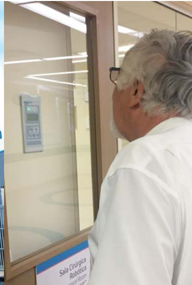
MK2430 Melde- und Prüfkombination mit LCD dient zur optischen und akustischen Signalisierung von Alarmmeldungen aus den Bender Systemen im „Robotics Surgery Room“ (OP mit Robotern)
